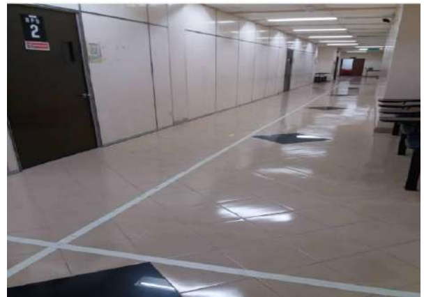
Lantai yang bersih, selamat dan tidak rosak
