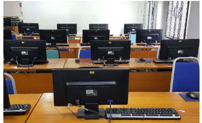
Pendawaian/kabel yang kemas dan selamat
